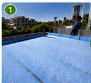
1. Sobreposição da LÂMINA IMPERMEABILIZANTE AXION
